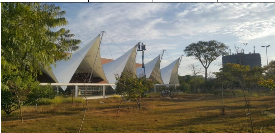
Foto: Nova cobertura instalada no prédio da BSP em 12/6/2020
