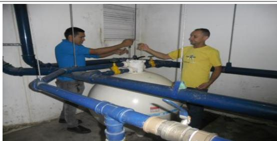
Foto 7 – Limpeza da cabeça de válvula dos filtros do espelho d'água
