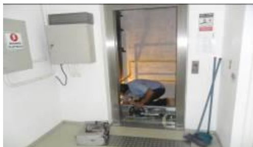
Foto 03 – MANUTENÇÃO PREVENTIVA DO ELEVADOR
