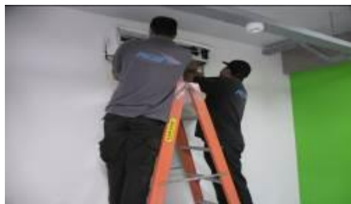
Foto 04 – MANUTENÇÃO PREVENTIVA DO AR CONDICIONADO
