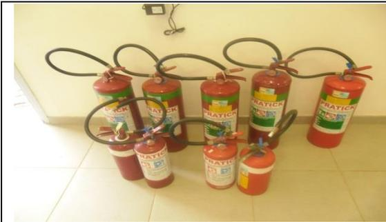
Foto 01 Recarga de 36 extintores, sendo 06 inspeção, 09 H2O, 18 CO2, e 03 teste hidrostático
