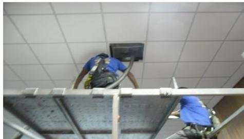
Foto 06 - LIMPEZA DOS DUTOS DO AR CONDICIONADO DO
