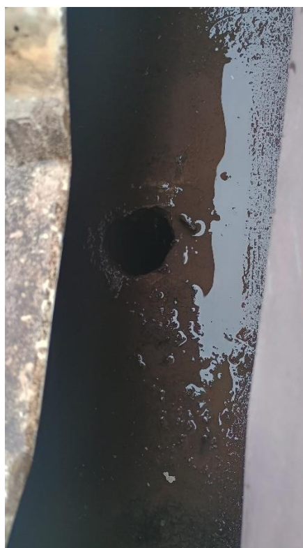
Detalhe do bocal da calha
