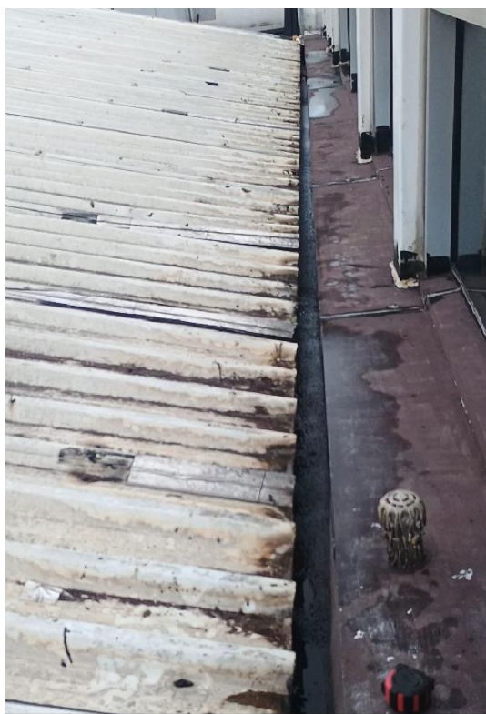
Cobertura no encontro com a calha
